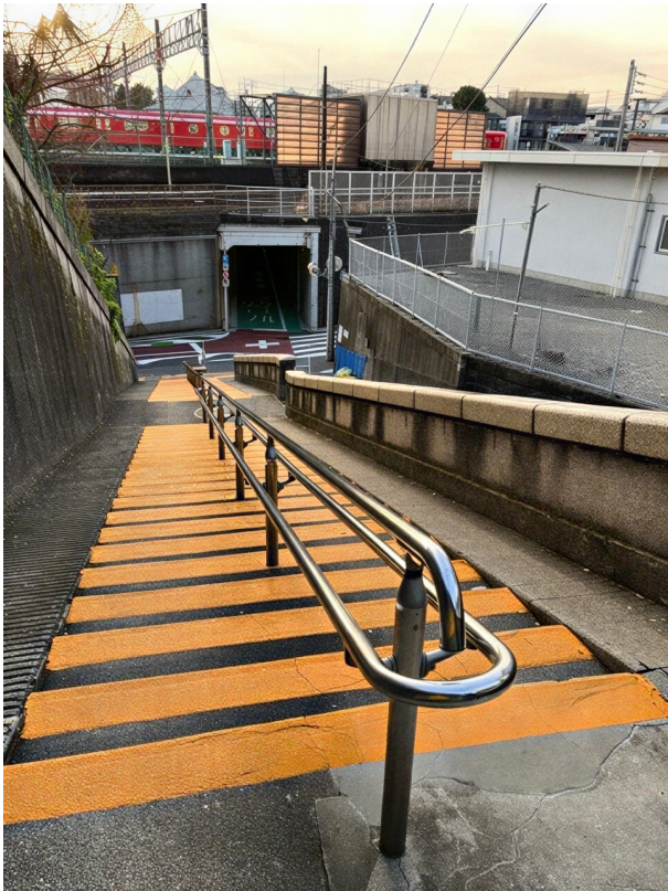
← Freilufttreppe im Großraum Tokyo. Ein stabiler Handlauf, taktile Leitsysteme und gelbe Markierungen am Boden ermöglichen Sehbehinderten eine sichere Passage. Für Rollstuhlfahrende jedoch ist die Treppe nicht passierbar.
