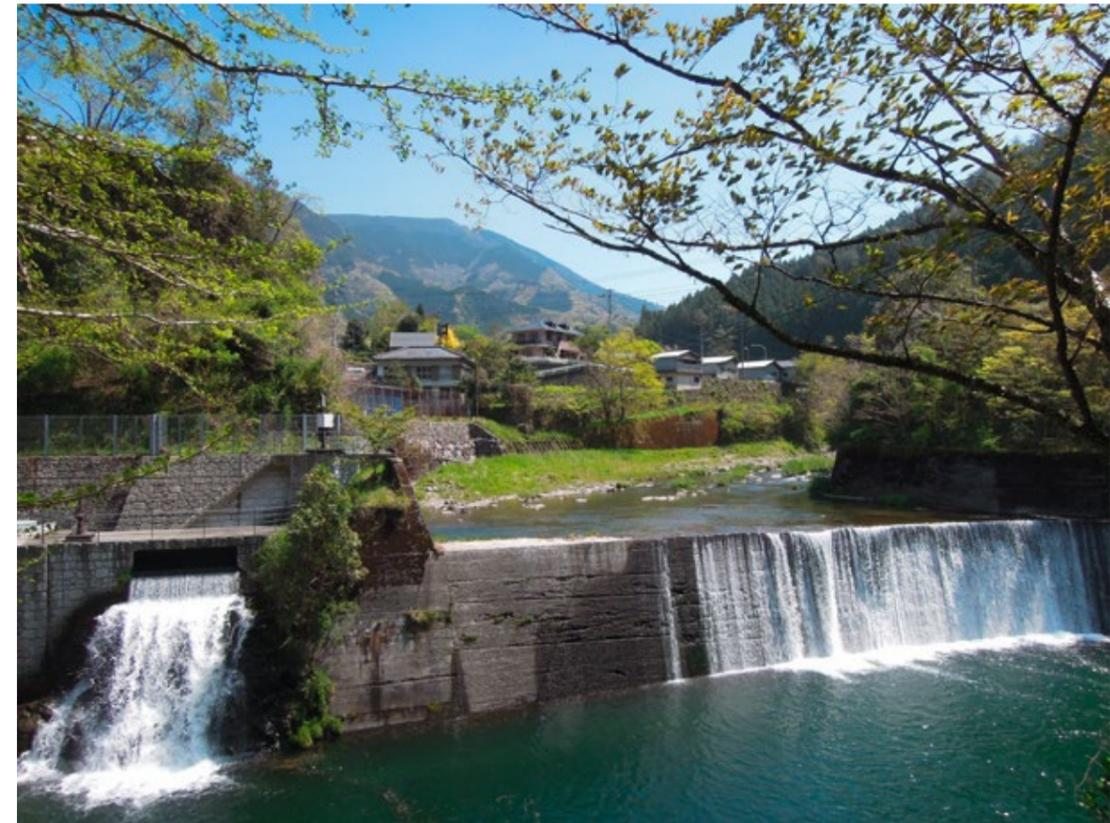
Wehr und Überlauf der Wasserkraftanlage in Yusuhara, Präfektur Kōchi. Mit einer Leistung von 53 kw versorgt sie tagsüber eine Schule und nachts die Stadtbeleuchtung.
